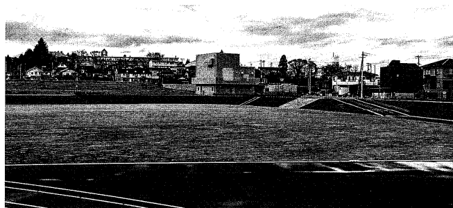
西川中央公園の再整備
