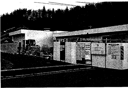
令和7年4月1日よりながめまらボの一部として供用開始に向けて改修中の「旧長沼老人福祉センター」
