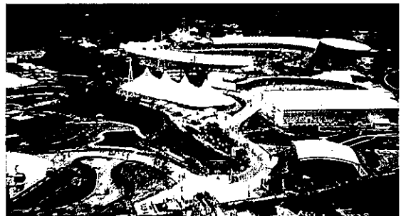
未来博会場全景 現在は工業団地・住宅団地としても利用されています
