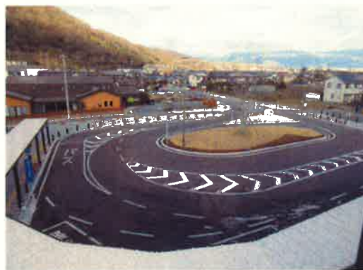
（北口広場の状況）
