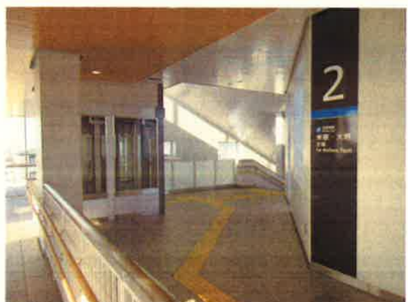
(こ線橋部分のエレベーター)
