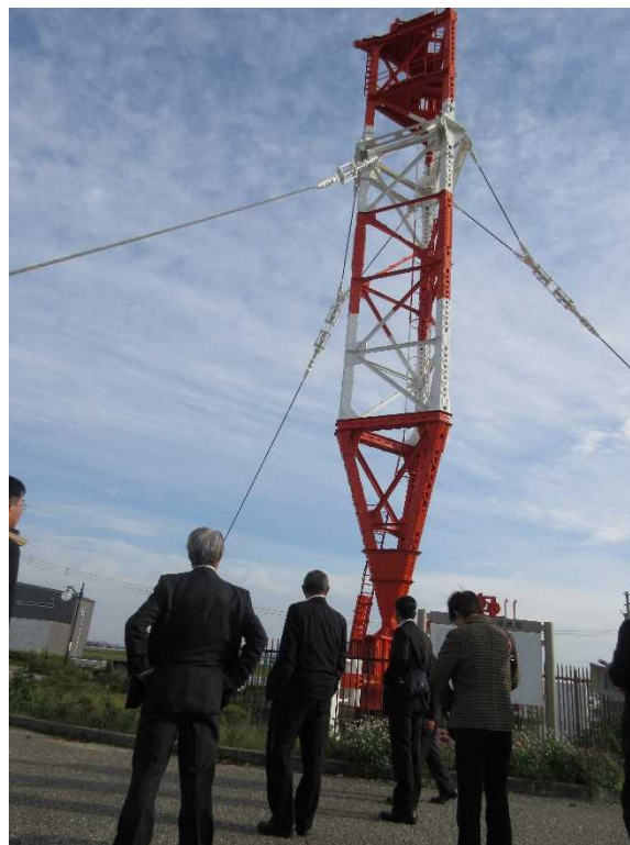
(「ニイタカヤマノボレ」の暗号電が送電されたと言われる依佐美送信所の鉄塔 当時は 250mもの高さであった。)
