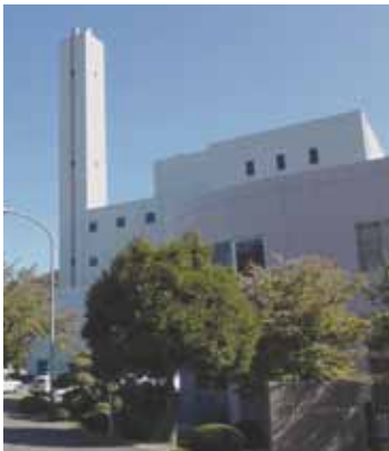
須賀川地方衛生センター
