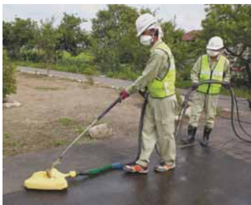
須賀川市内の除染状況
