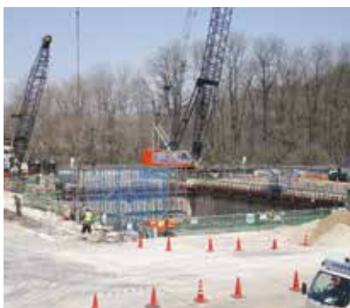
建設中の新ごみ処理施設
