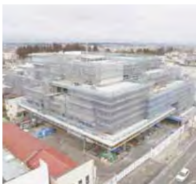
建設中の市民交流センター
