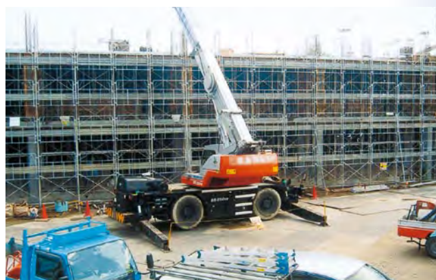
建設が進む第三小学校
