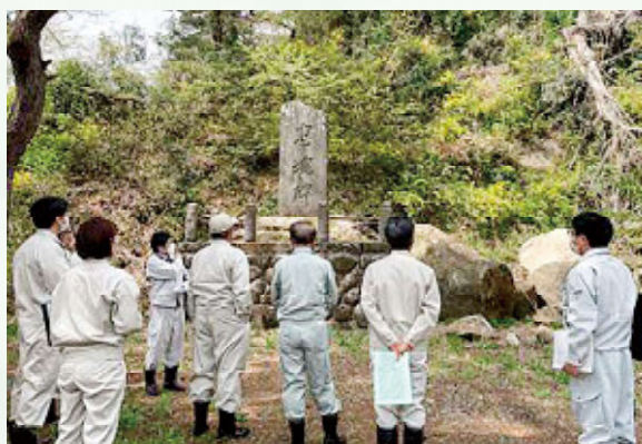
地震による落石状況を確認（長沼城址）
